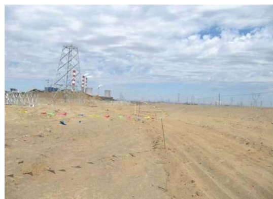
塔基施工场地彩条旗围护
