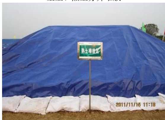
临时堆土苫盖
