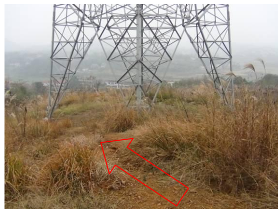
施工及人抬道路植被恢复
