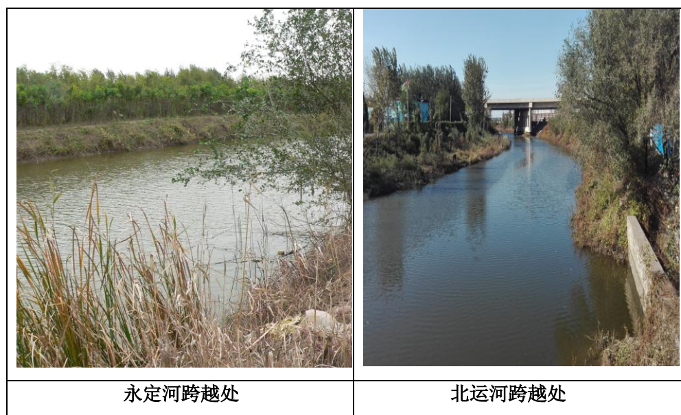
图 4.2-2 本工程输电线路跨越河流现状照片
