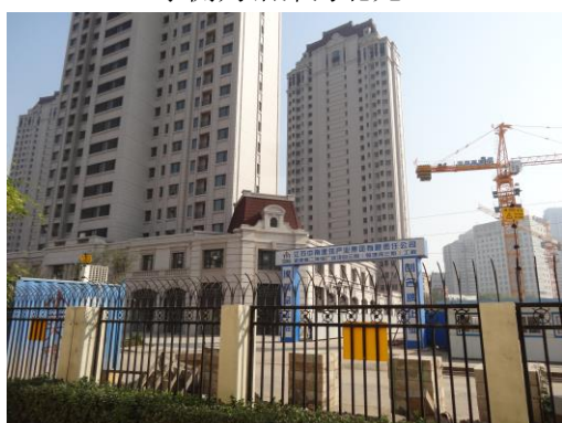
铂津湾南苑（铂津湾三期，在建）
