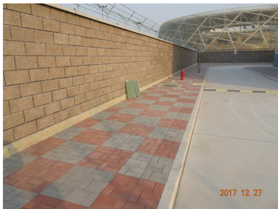
变电站透水砖铺装
