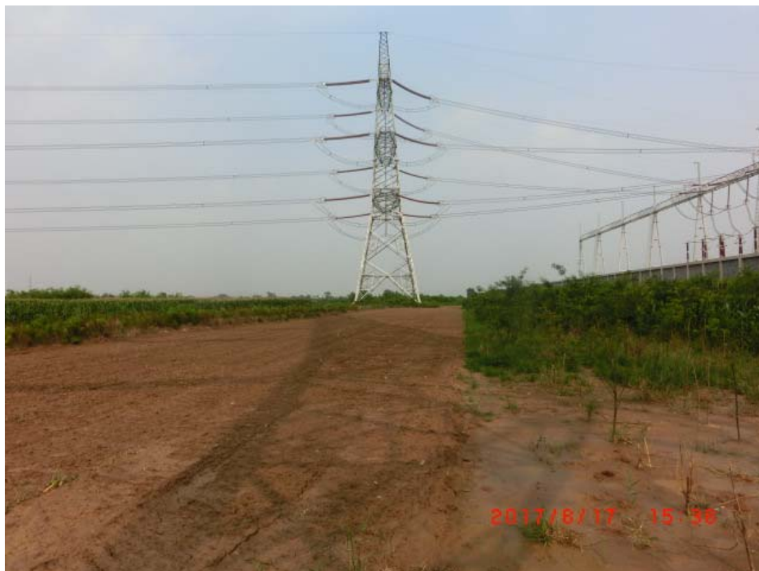
土地整治工程（施工道路区）
