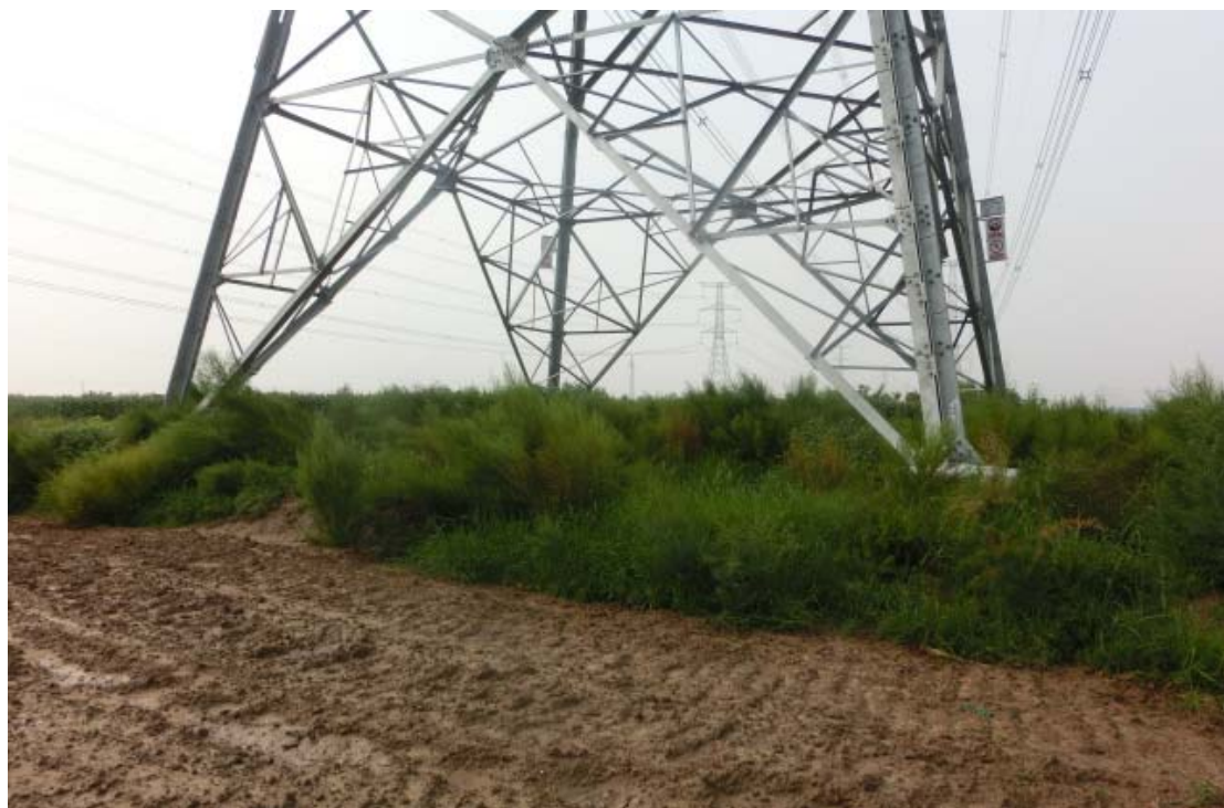
植被建设工程（塔基区）
