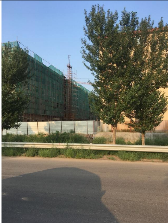
附图 4-5 变电站东侧在建住宅楼
