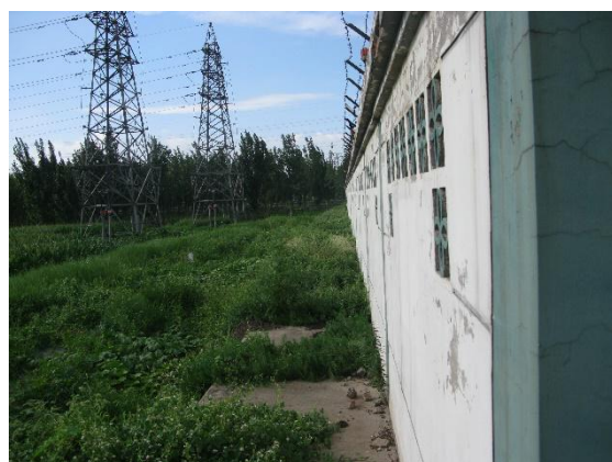
附图 3-3 变电站西侧现状
