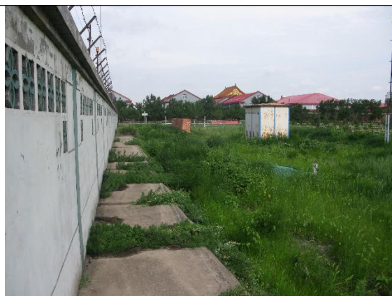
附图 3-2 变电站南侧现状
