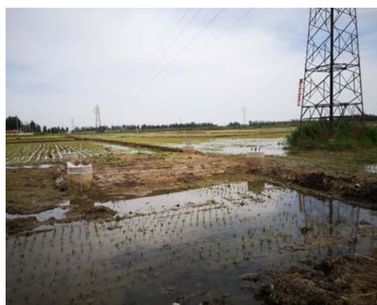
土地整治工程
