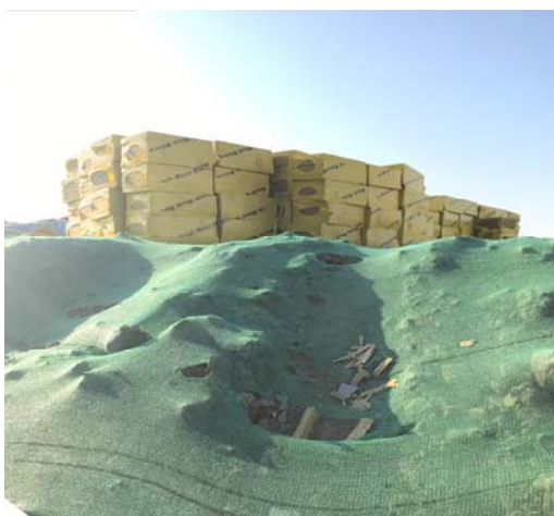
临时防护工程 密目网苫盖
