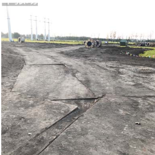
临时防护工程 钢板铺垫
