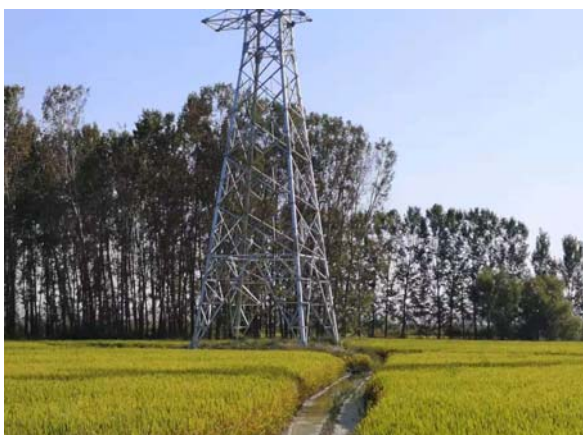
植被建设工程 撒播草籽
