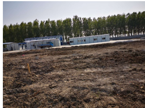
袁罗变电站现状
