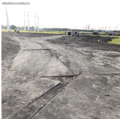
临时防护工程 钢板铺垫
