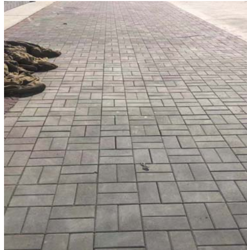
降水蓄渗工程 透水砖铺设
