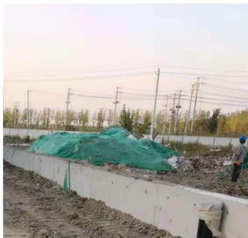
临时防护工程 密目网苫盖
