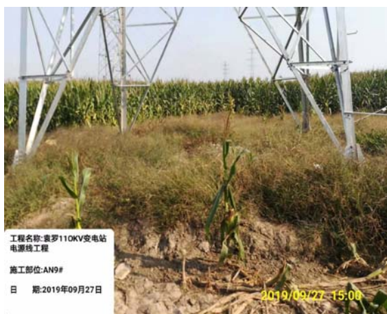
植被建设工程 撒播草籽
