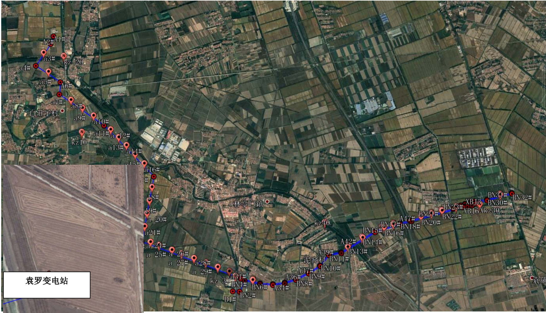
建设前袁罗 110 千伏变电站及输电线路
